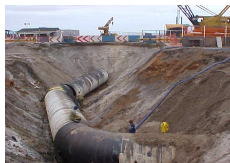
Trecho terrestre de aço
