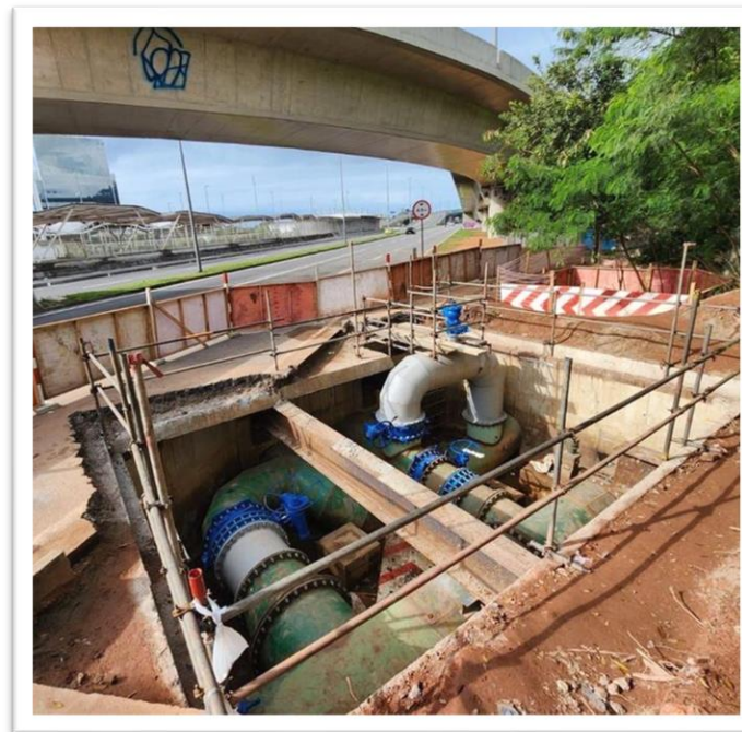
Substituição de válvula reservatório Outeiro
