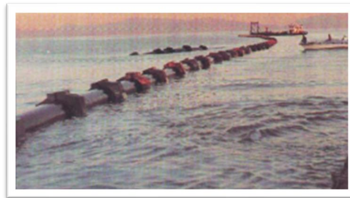
Transporte com contra peso do tramo
