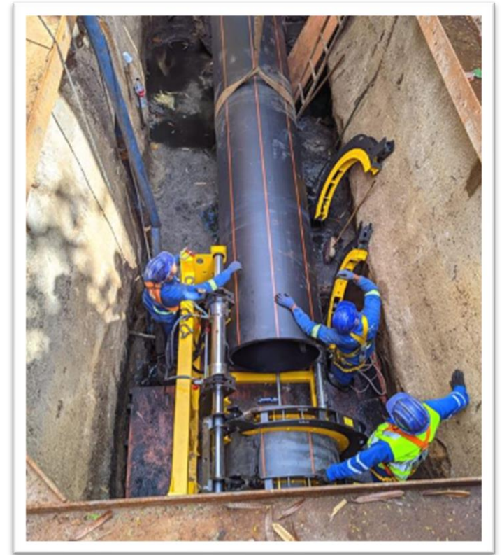
Preparação do Sliplining
