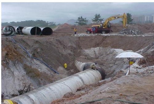
Trecho terrestre de aço
