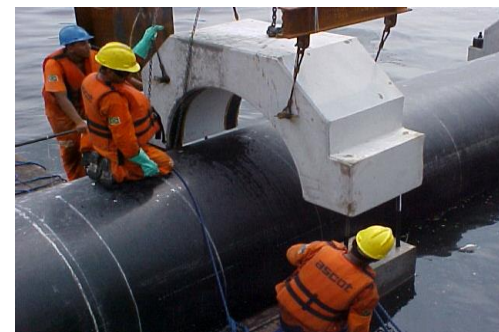
Instalação dos blocos de ancoragem
