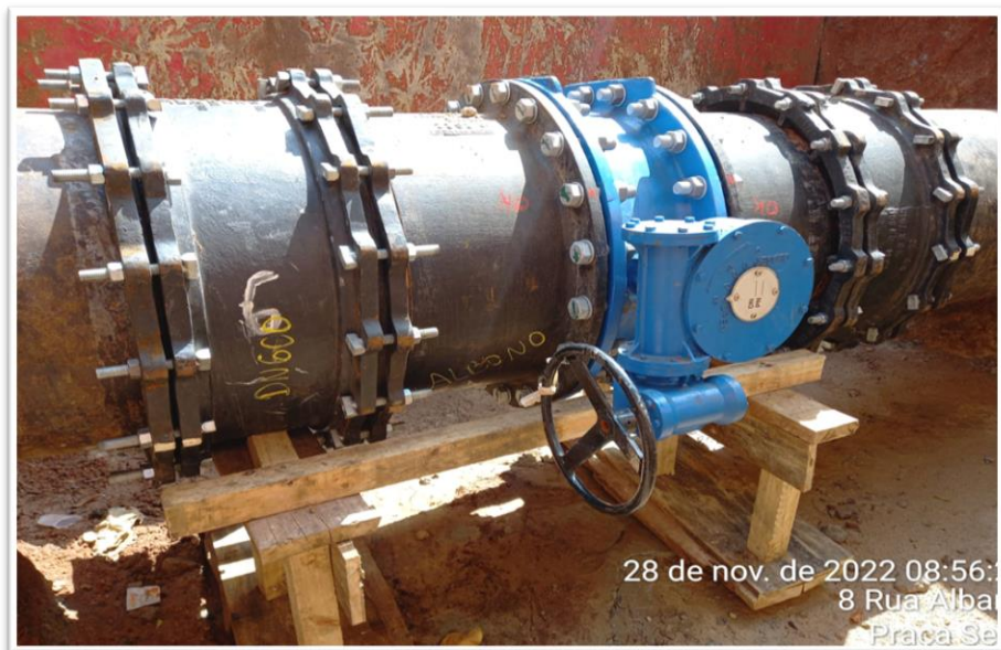
Troca de válvulas do Albano
