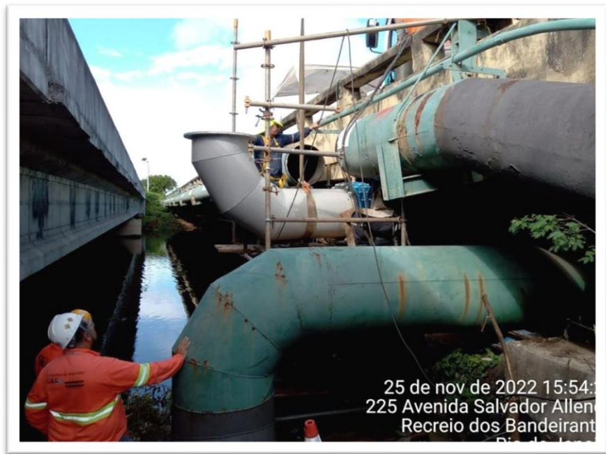
Interligação da adutora próximo a Ilha Pura
