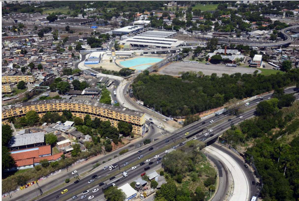
Viaduto do Camboatá
